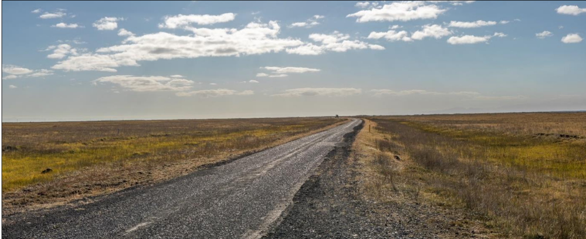
Mynd 5.1 Mynd tekin á Meðallandsvegi í átt að fyrirhuguðu framkvæmdasvæði.
